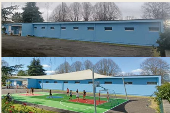
Exemple de voile d'ombrage à l'École Wallon-Debussy
